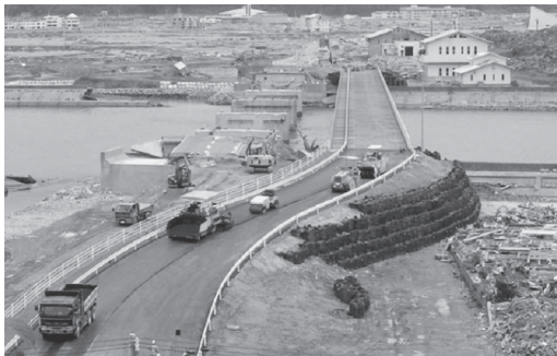
図1 気仙大橋仮橋を宮城県気仙沼市側から望む
