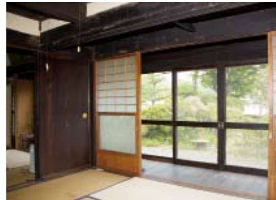
天井は屋根に合わせて、高いところと低いところがある。表面は防腐用に柿渋が塗られている
